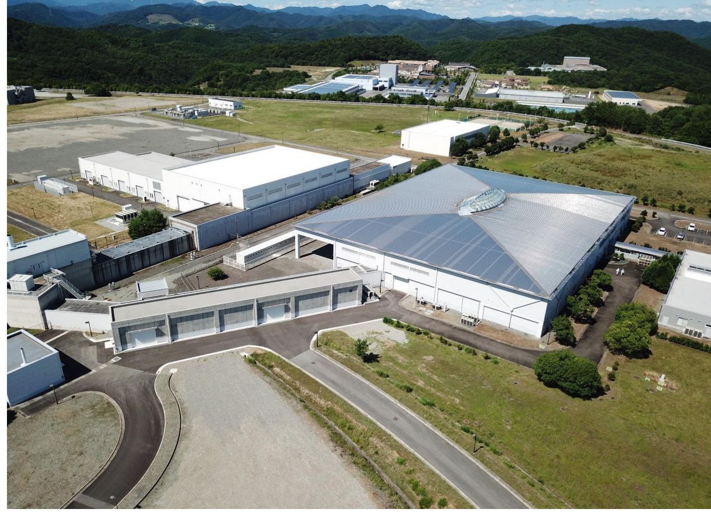
NewSUBARU 全景写真 SPring-8サイト内に設置された大学所有施設 周長 119 m
